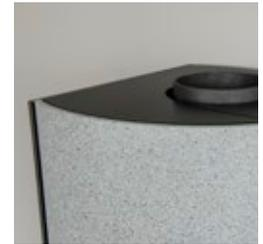
Die Abdeckplatte aus Stahl verbindet die Steinelemente mit der Glasfront.
